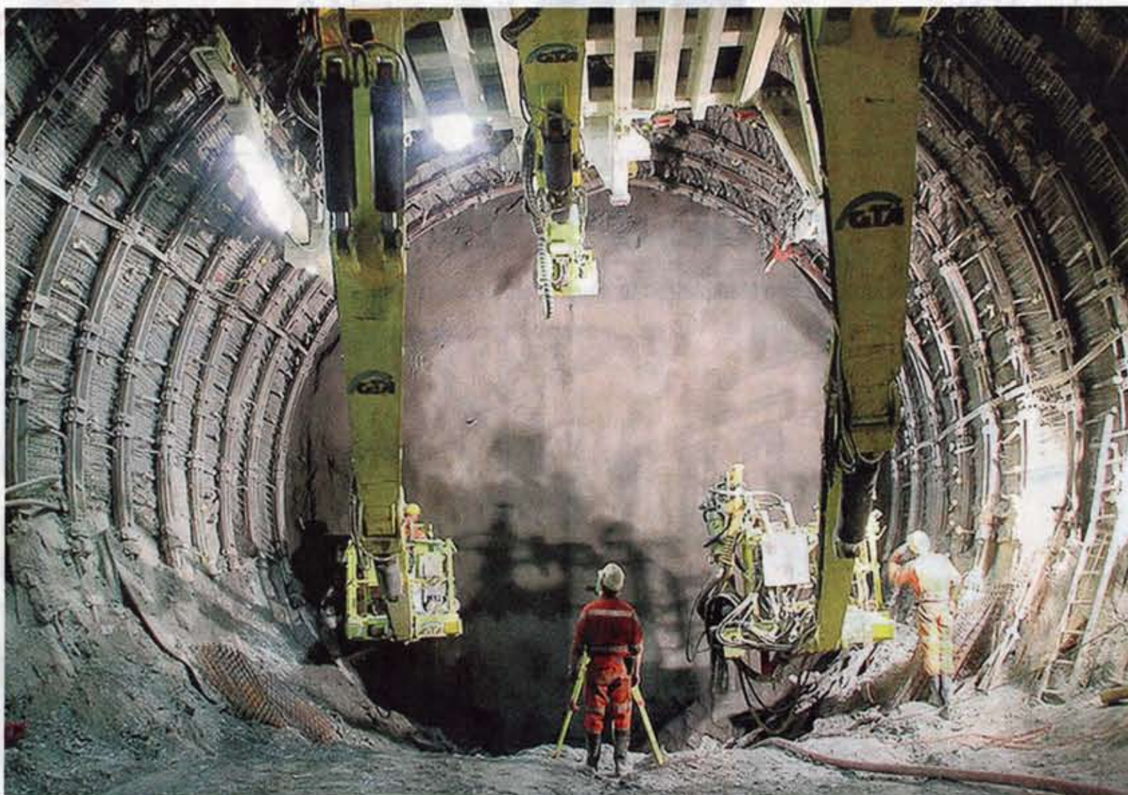
Die Hosch-Fördertechnik GmbH sorgt mit speziellen Abstreifsystemen im Schweizer Gotthard-Massiv dafür, dass das Zehn-Milliarden-Projekt „Gotthard-Basistunnel“ nicht ins Stocken gerät. Dank der Technik aus dem nördlichen Ruhrgebiet laufen die Förderbänder, die Abraum und Geröll aus dem Berg ans Tageslicht bringen, rund um die Uhr. Fotos: Fremdbild
