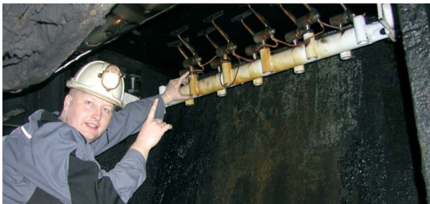
Maciej Majewski überprüft die HOSCH-Technik unter Tage
