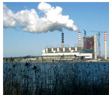
Volle Energie: das Kraftwerk Patnow
