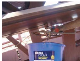
Die Messung zeigt Materialrückstände auf dem Gurt
