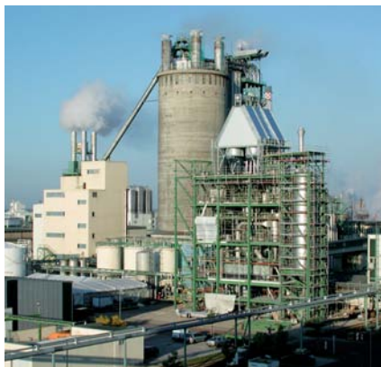
1993 ging die moderne Anlage in Betrieb
