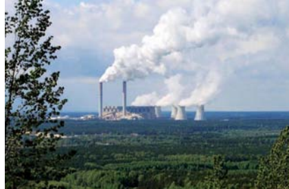
Das Kraftwerk Belchatow liefert 4.440 Megawatt
