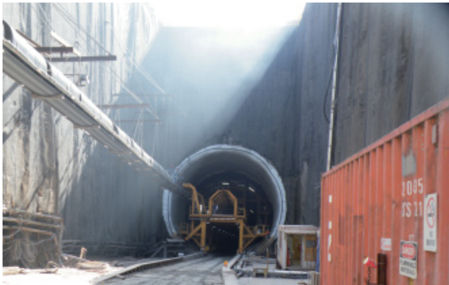
Der Eingang zum Monster-Tunnel, der mehr als zehn Kilometer lang wird
