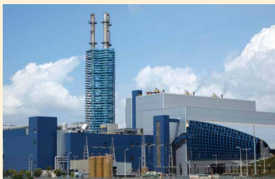
Die Müllverbrennungsanlage in Neapel.
