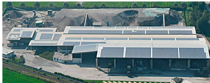
Im Werk in Lomello wird Asche gesammelt und über ein komplexes Gurtbandsystem befördert und aufbereitet.
