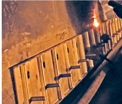
Der erste Testlauf des FD-Seitenabdichtungssystems am 1.600 mm breiten Gurtband in einem Zubringertunnel mit sechs Aufgabepunkten.
