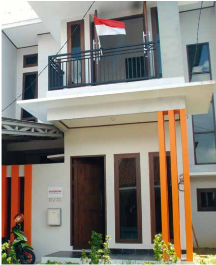
Büro und Lager im Erdgeschoss, Wohnungen im 1. Stock – der Firmensitz von HOSCH in Indonesien.
