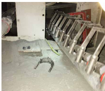
Der D2-Abstreifer bei der Arbeit im Steinbruch von Norsk Stein A/S.
