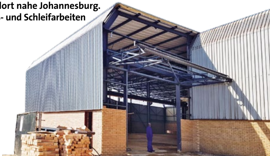
Durch den Anbau vergrößert sich das bestehende Gebäude von HOSCH Südafrika um ca. 1.000 Quadratmeter. Ende Januar 2021 soll das Projekt abgeschlossen sein.
