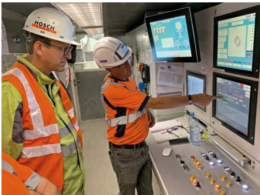
Ansgar Frieling (li.) mit einem Eiffage-Techniker in der Schaltzentrale des Tunnelvortriebes unter der Erde von Paris.
