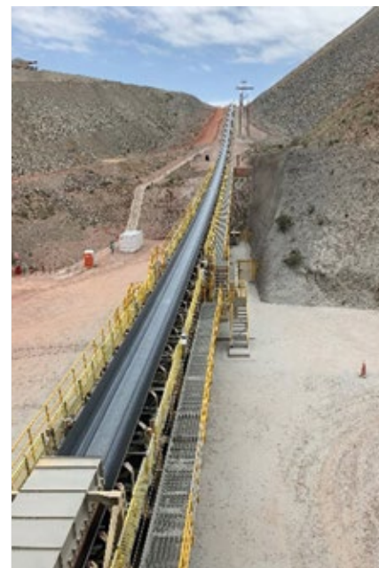
HOSCH e:zslide-Abstreifer sorgen für mehr Effizienz und Sicherheit auf den Förderbändern in der Kupfermine in Arequipa.
